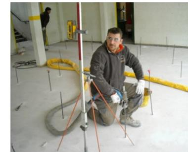
La disposition des forages est fonction de la géométrie de la cavité et doit permettre un remplissage optimal en tout point. Elle conduit généralement à un maillage d'injection d'environ 2 m x 2 m. Dans tous les cas, celui-ci ne peut excéder le maillage maximum des préconisations de l'IGC en injection de carrière et rappelé ci-avant.
