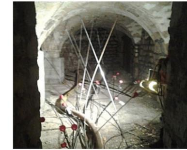
Exemples de disposition des tubes d'injection dans des cavités
