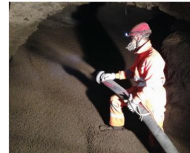
Usuellement, les billes d'argile sont propulsées et injectées à sec afin qu'il n'y ait pas d'injection d'eau dans la cavité pendant les travaux. Toutefois il est fréquent d'humidifier les billes lors du soufflage pour diminuer la poussière générée en sous-sol et conserver une visibilité pour l'équipe présente dans la cavité. L'humidification se fait par pulvérisation de fines gouttelettes d'eau au niveau de la pompe de soufflage.
